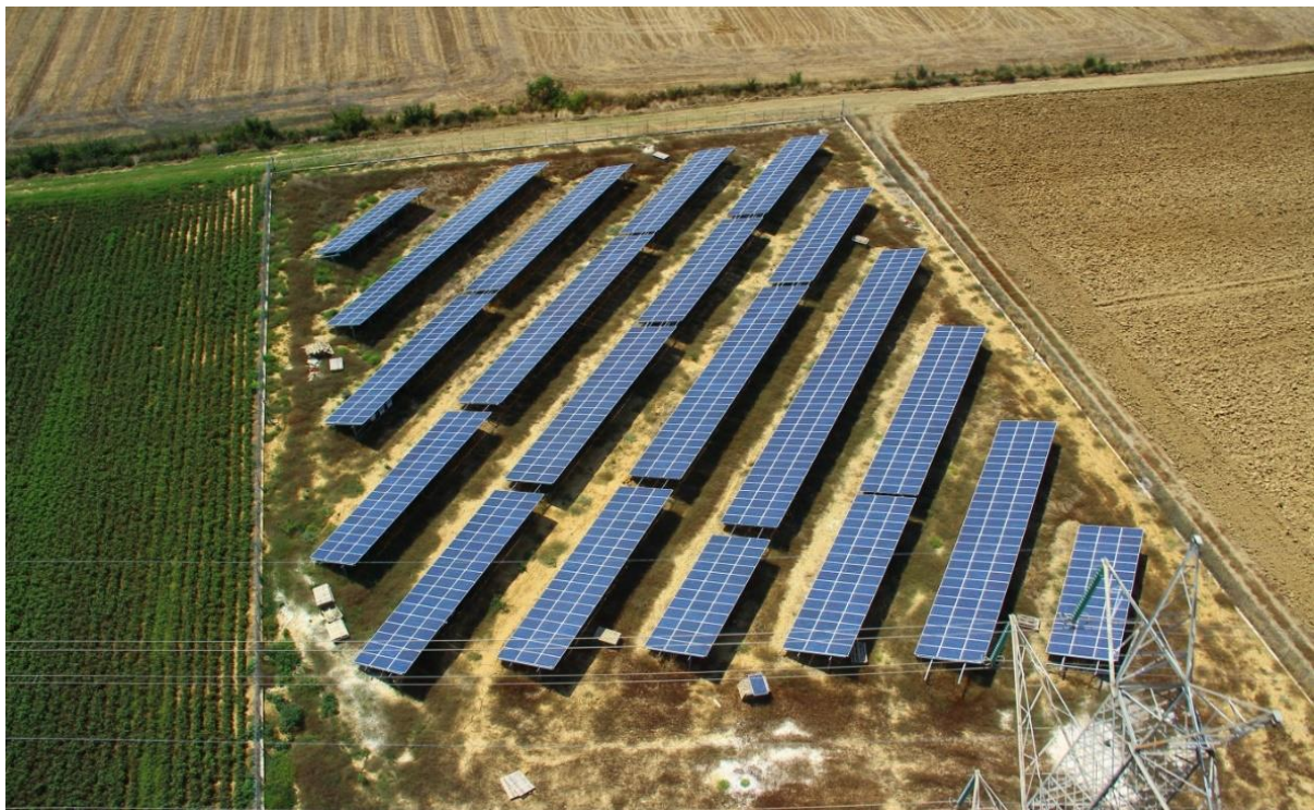
Φωτ. 6 Πτήση πάνω από τον πυλώνα και τα καλώδια υψηλής τάσης
