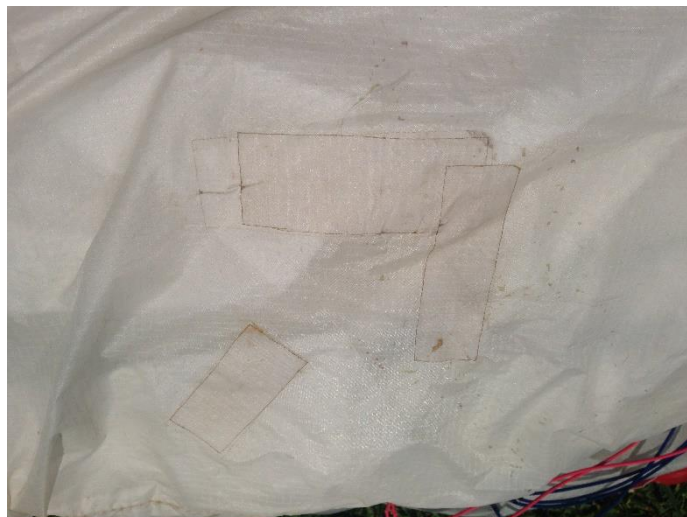
Φωτ. 4 Σημεία Επισκευής
