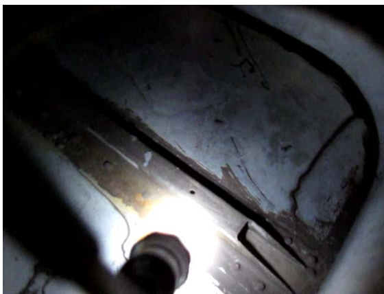
Φωτ. 21: Η αριστερή δεξαμενή κατά την αρχική εξέταση.
