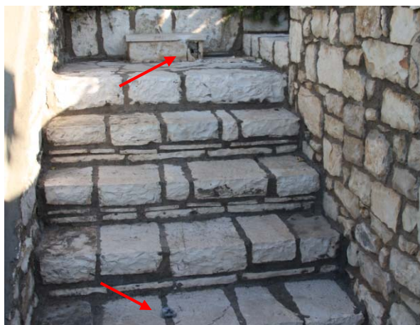
Φωτ. 1: Άποψη του μεταλλικού θραύσματος και της προκληθείσας ζημιάς.
