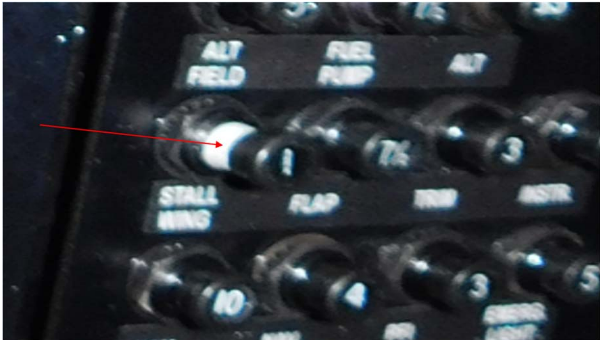
Φωτ. 5: Η Θερμική Ασφάλεια του Κυκλώματος Απώλειας Στήριξης απενεργοποιημένη.
