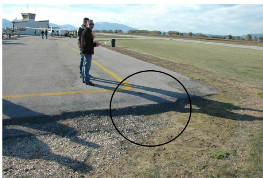
Φωτ. 2. Σημείο συναρμογής ασφάλτινης και καλυμμένης με βλάστηση επιφάνειας.
