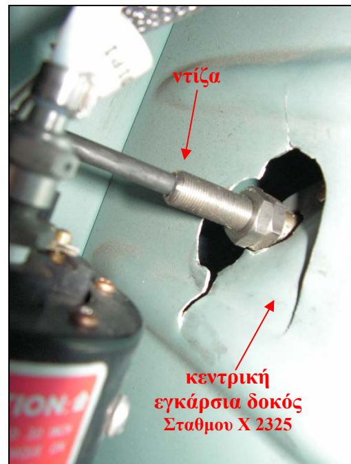
Φωτ. 2: Ρωγμή κεντρικής εγκάρσιας δοκού (οπίσθια όψη)
