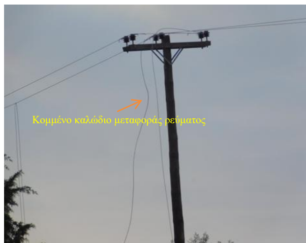
Φωτ.1 : Η ΥΠΑΜ στο σημείο πτώσης και το κομμένο μη τροφοδοτούμενο ηλεκτροφόρο καλώδιο
